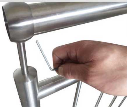
Handlauf befestigen: Bei Trägerplatte: Bohrschraube in die vorgebohrten Löcher Schrauben. Bei Kugelring: Seitliche Madenschraube Anziehen.
